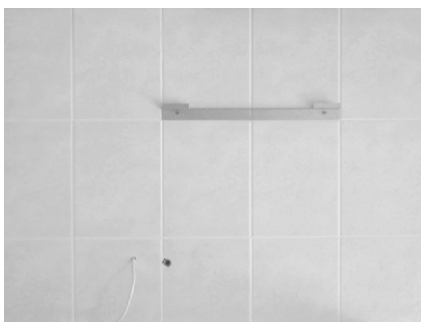
Pokaz przygotowania zasilania elektrycznego. napięcia, odpływu kondensatu i montażu konsoli.
