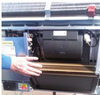
Retirez le couvercle du déshumidificateur. Portez une attention particulière aux connecteurs du contrôleur, tels que les câbles et les antennes.
