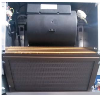
Dévissez les 2 vis du côté droit et desserrez légèrement les 2 vis du côté gauche.
