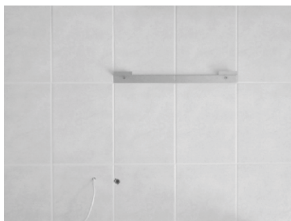
Démonstration de préparation de l'alimentation électrique, tension, évacuation des condensats et montage de la console.
