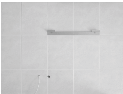
Az elektromos ellátás előkészítésének bemutatása. feszültség, kondenzvíz-elvezetés és a konzol felszerelése.
