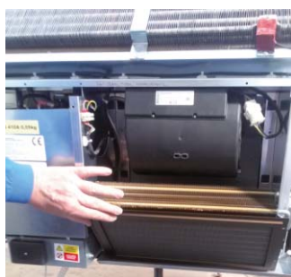
Távolítsa el a páramentesítő fedelét. Fordítson különös figyelmet a vezérlő csatlakozóira, például a kábelekre és az antennákra.
