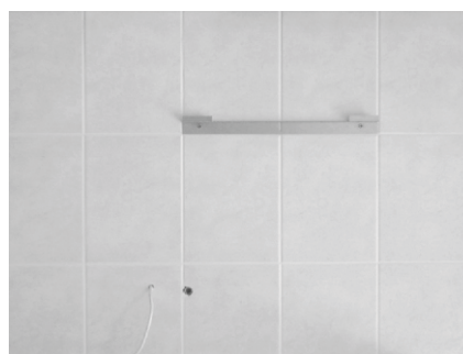
Demonstration der Vorbereitung der Stromversorgung. Spannung, Kondensatablauf und Montage der Konsole.
