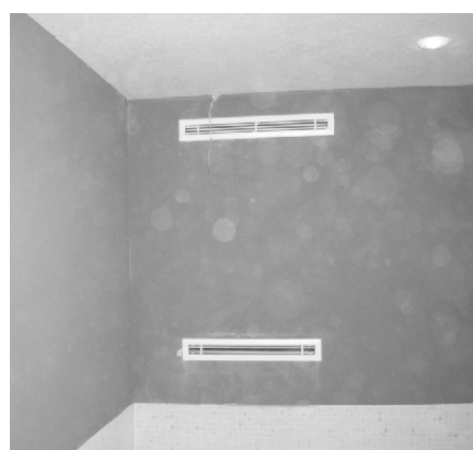
Ansicht aus dem Schwimmhallenraum
