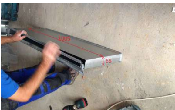
5. Namontovanie krytu odvlhčovača
