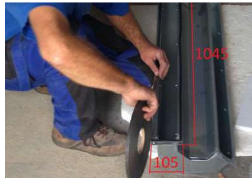
6. Skrátenie potrubia podľa hrúbky steny - rezať zo strany príruby
