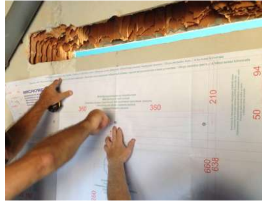
2. Vymeranie konzoly pomocou šablóny
